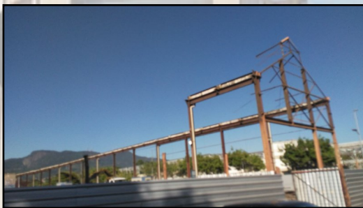
Estrutura de Praia Formosa sendo desmontada para a construção de um edifício.
