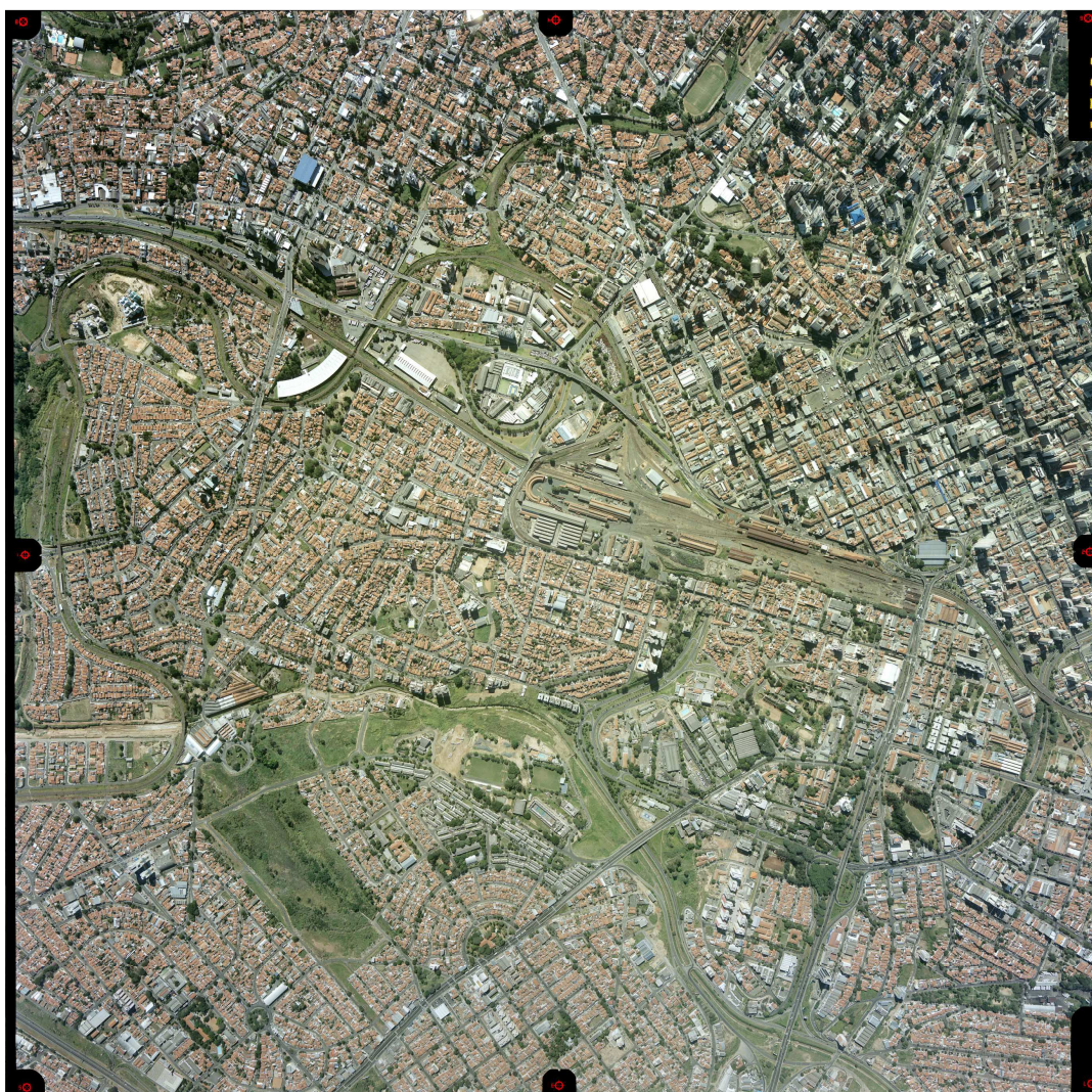
Fig. 88 – Base SANASA/2002 - 3414_05_0021 – Região Central – Campinas. Prefeitura Municipal. Sociedade de Abastecimento de Água e Saneamento S/A.
