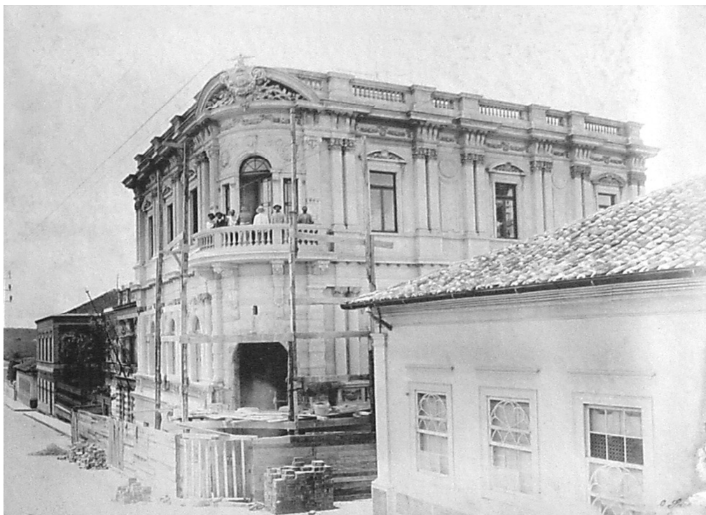
Fig. 23 - Escritório Central da Companhia Mogyana , Pavilhão Campos Sales em construção. Campinas/SP. 1910. Álbum Companhia Mogyana de 1910. Museu da Companhia Paulista.
