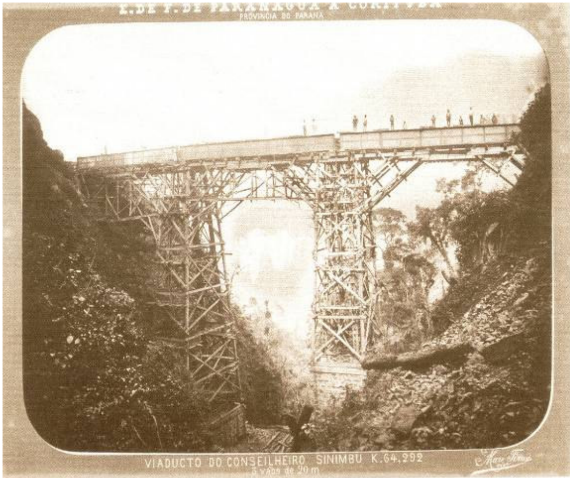
Figura 14 Fotografia de Marc Ferrez Viaduto do Conselheiro Sinimbu Estrada de Ferro Paranaguá a Curitiba Paraná, 1879 Coleção Charles Wiener, Quai d'Orsay
