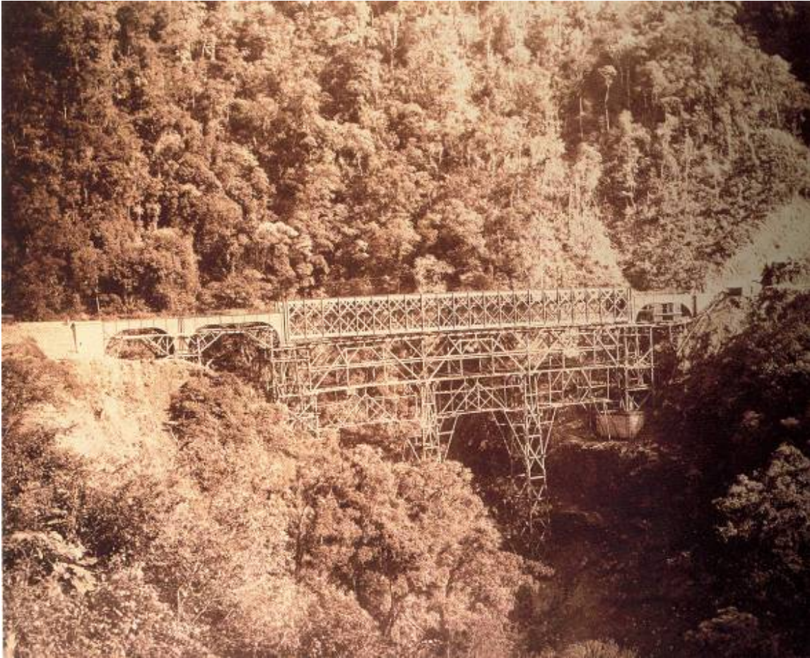
Figura 15 Fotografia de Marc Ferrez Viaduto da estrada de ferro Curitiba-Paranaguá Paraná, c. 1885 Coleção do Museu Imperial
