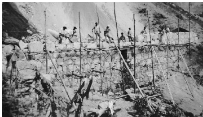
Figura 18: Construção de muro de contenção para a Estrada Rio-Petrópolis na Serra de Petrópolis (RJ), em 1927 ou 1928 – A fotografia exhibe riscos a que estavam expostos os trabalhadores e o fato de o trabalho ser quase exclusivamente manual. Fonte: CONCERT (2009 apud CÉU-ABERTO; CONCERT, 2010, p. 15).
