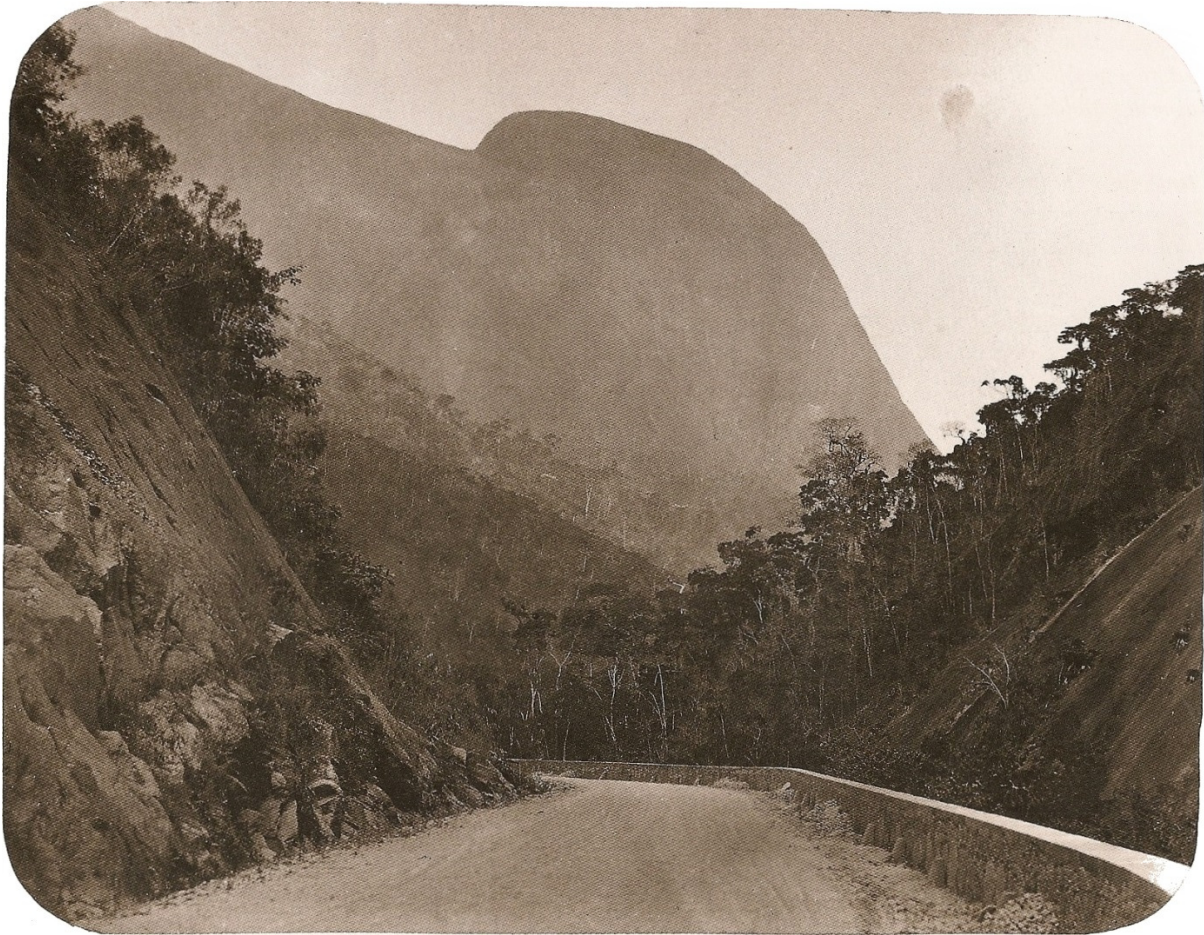
Figura 6: Serra do Taquaril (RJ), em fotografia de Revert-Henry Klumb (ano entre 1863 e 1868) – Em primeiro plano, a Estrada União e Indústria; ao fundo, um dos paredões rochosos que compõem a serra; à esquerda, percebe-se o corte íngreme da encosta feito pela rodovia. Fonte: Klumb (1872, sem paginação apud VASQUEZ, 1998, p. 42)
