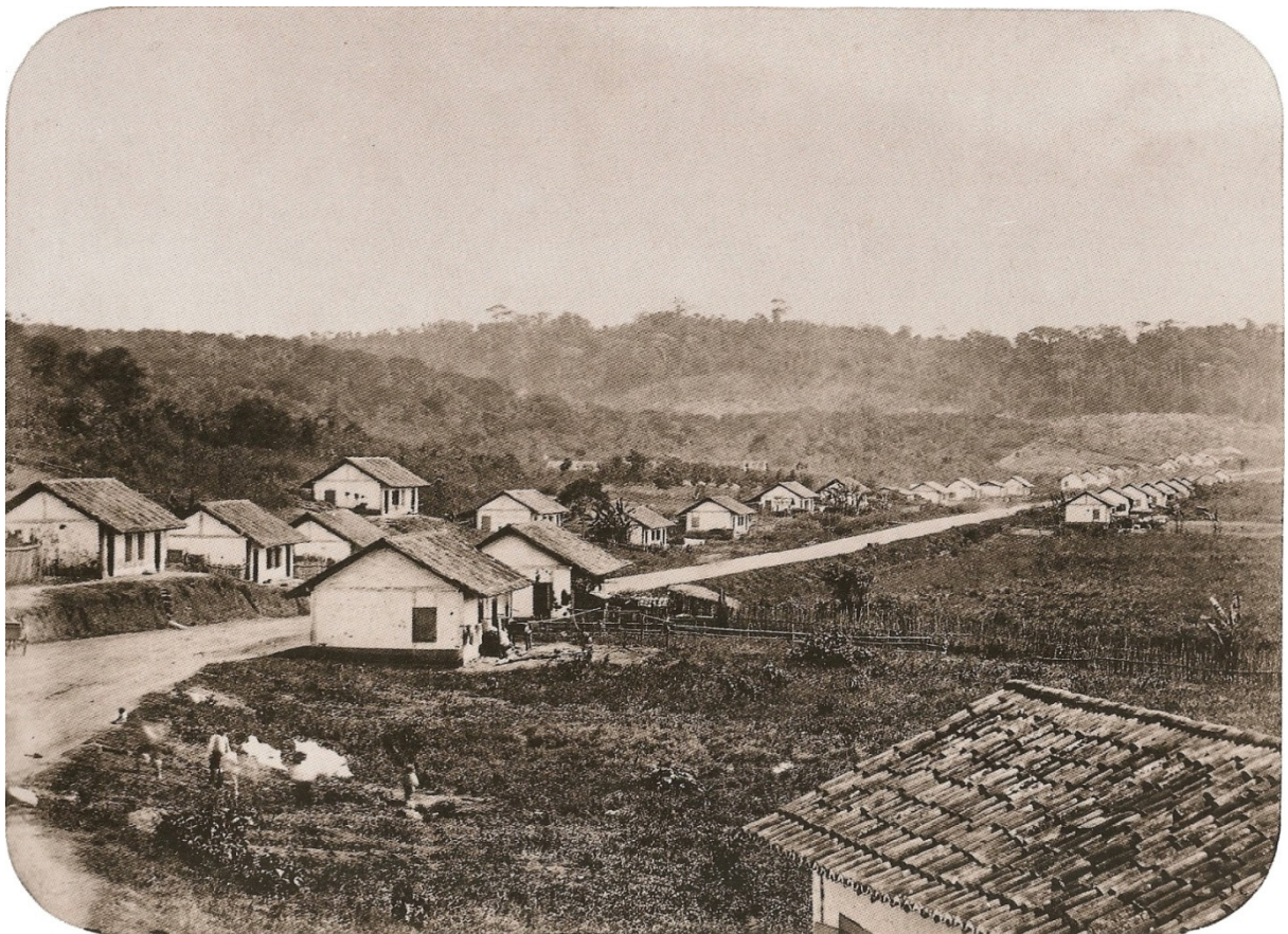
Figura 4: Colônia D. Pedro II (Juiz de Fora, MG), em fotografia de Revert-Henry Klumb (ano entre 1863 e 1868) – Percebem-se possíveis lotes para agricultura na retaguarda das casas. O arruamento em questão parece ser o que originou a atual Rua Bernardo Mascarenhas, no bairro Fábrica. Fonte: Klumb (1872, sem paginação apud VASQUEZ, 1998, p. 85).
